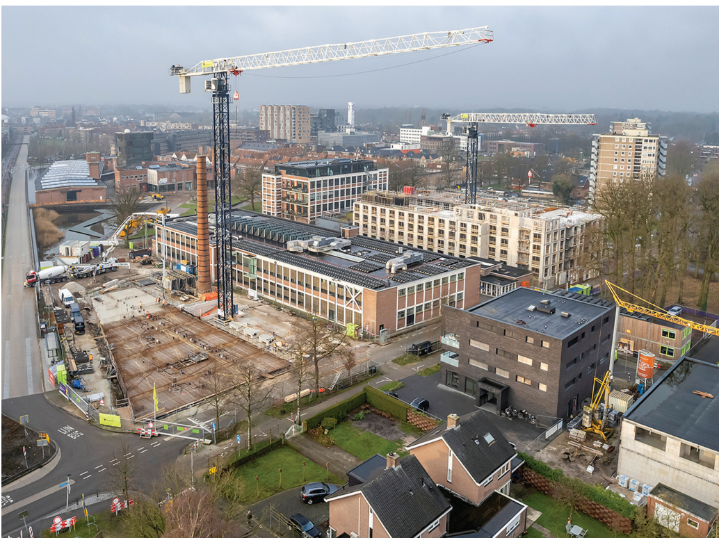
Figuur 19 – Stort begane grondvloer/dek van Tetem III (op de achtergrond is de ruwbouw van Tetem IV op hoogte).
