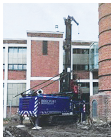
Figuur 7 – Aanbrengen van schroefinjectiepalen rond de schoorsteen.
